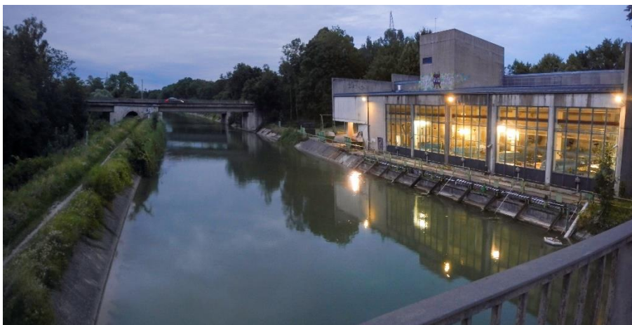
Abb. 22: Beleuchtetes Wasserkraftwerk Isar-Kanal
