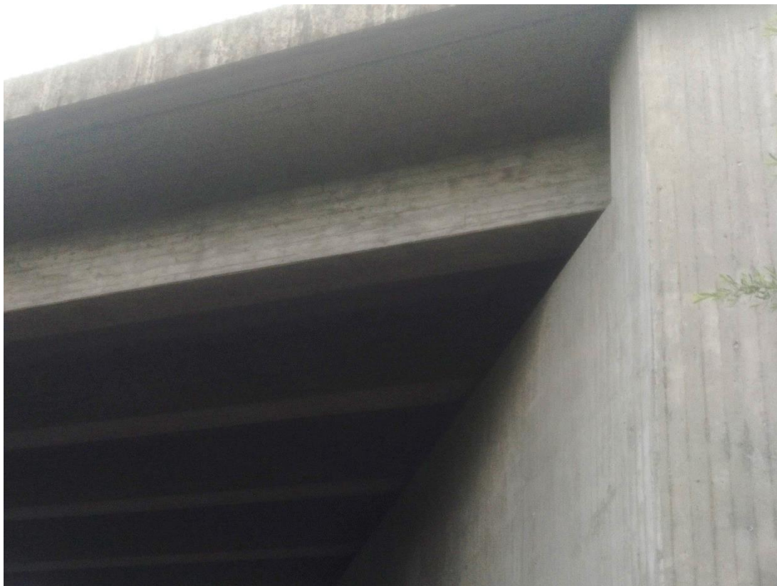
Abb. 4: Südwestliche Seite der Brücke über die Dorfen
