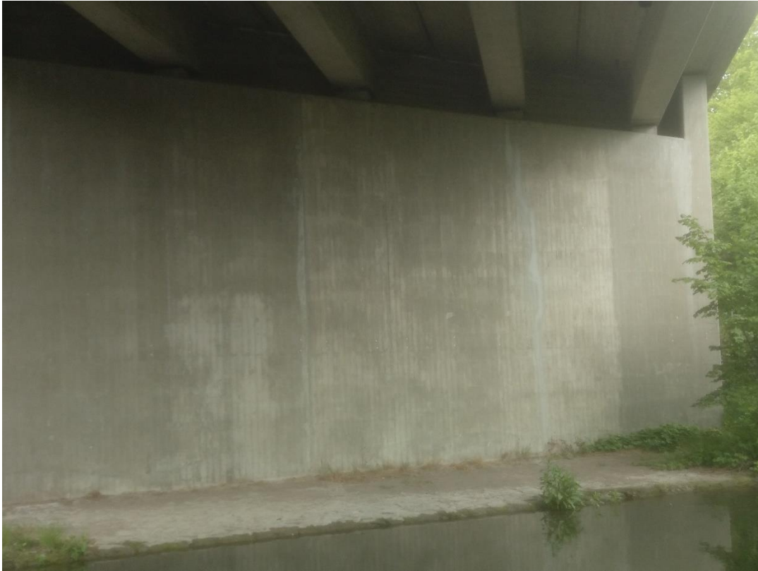
Abb. 1: Nördliche Seite der Brücke über die Dorfen
