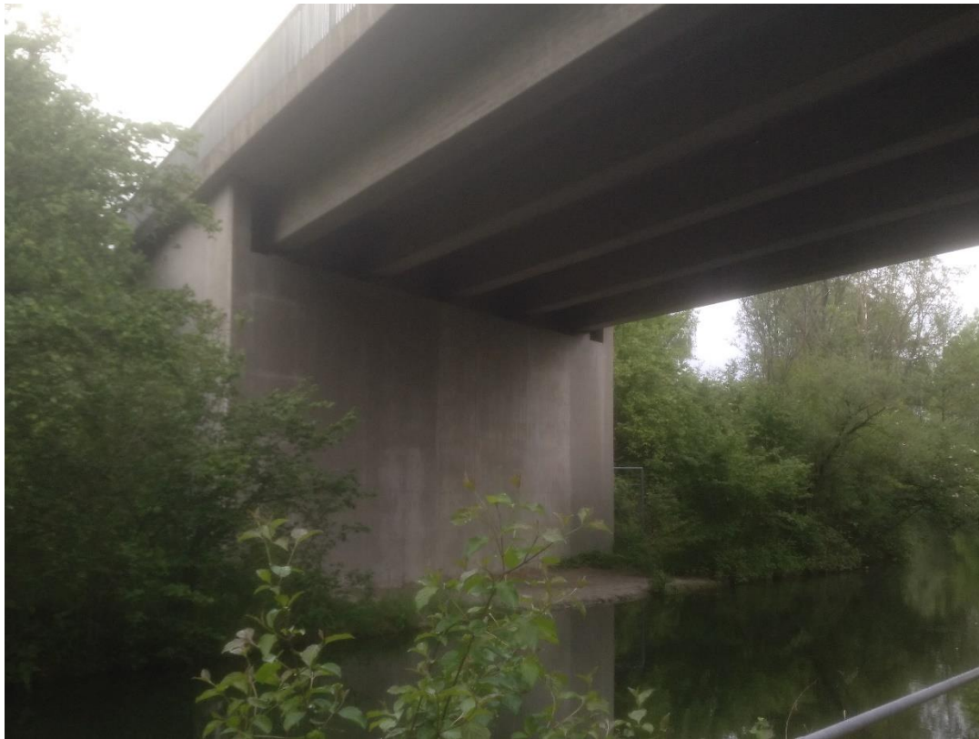
Abb. 3: Nordwestliche Seite der Brücke über die Dorfen
